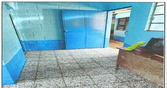
Foto 3: Mantenimiento de Puertas (Después)
