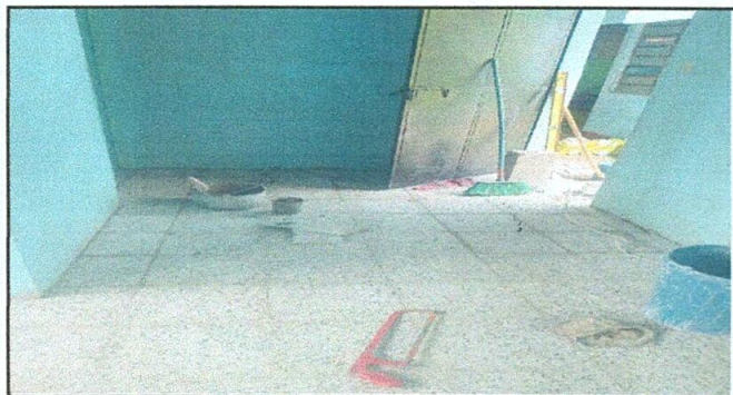
Foto 2: Mantenimiento de puertas (Durante)
